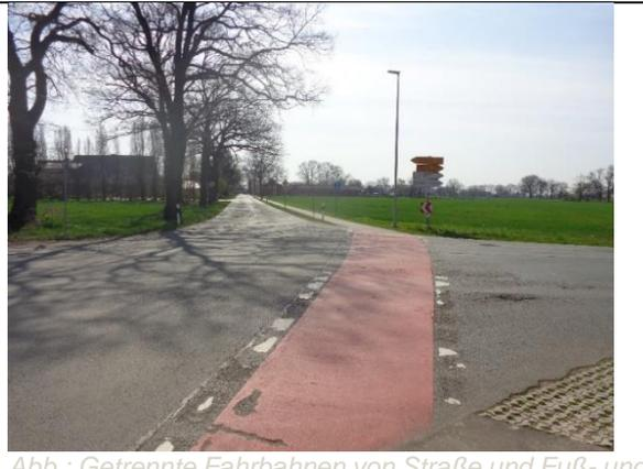
Abb.: Getrennte Fahrbahnen von Straße und Fuß- und Radweg mit Markierung in schlechtem Zustand
