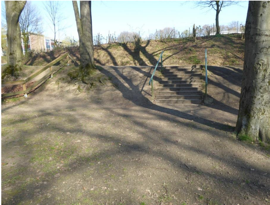
Vorhandene Treppe vor dem Schießstand
