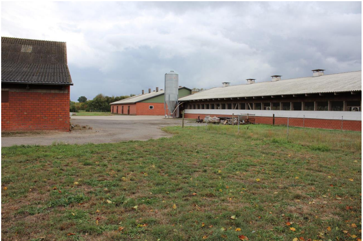
Abb. 1: Blick über einen Teil des Plangebiets mit den bestehenden Putenmastanlagen. Blickrichtung Südosten, 21.09.2018.
