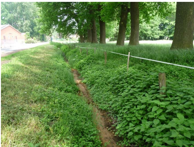
Abb. 5: Graben an der Teichstraße, stellenweise trocken.
