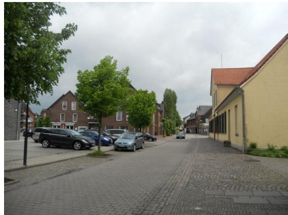
Foto 10: Große Straße - Defizit Eingangs- bereich
