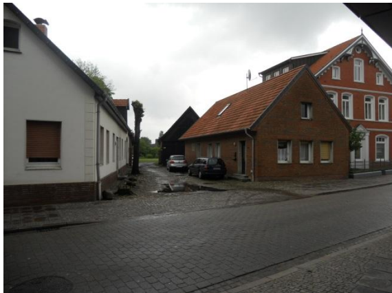
Foto 9: Mühlenstraße - Baulücke/ Sanierungsbedarf
