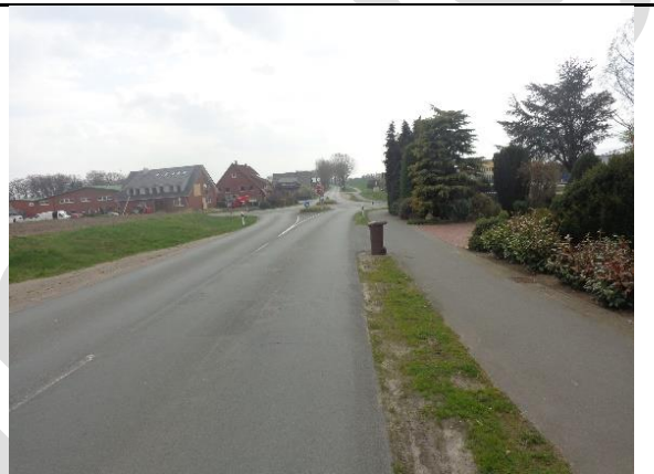
Abb.: Teilweise fehlende Fahrbahnmarkierung - Kirchstraße
