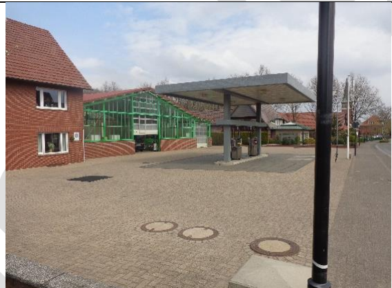
Abb.: Ehemalige Tankstelle
