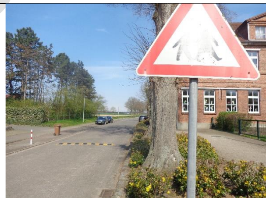
Abb.: Gefahrenzeichen Fußverkehr an der Schule mit Bremsschwellen zur Verkehrsentschleunigung
