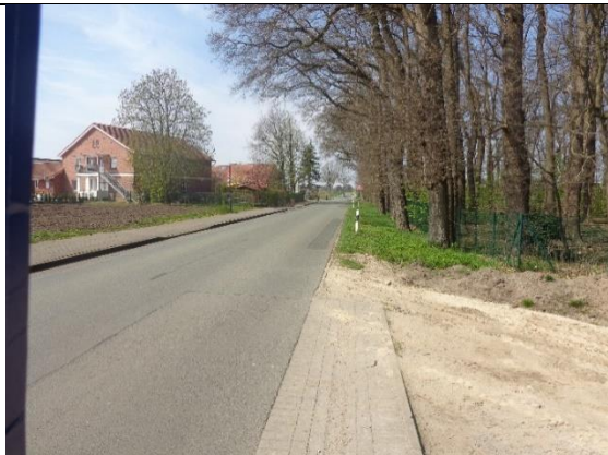
Abb. Getrennte Fahrbahnen von Straße und Fußweg, Gefahrenzeichen Radverkehr
