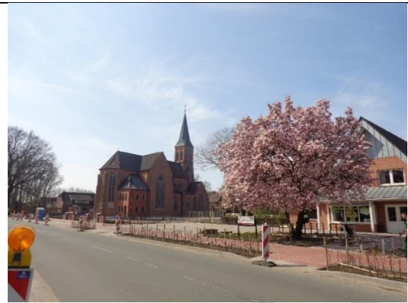
Abb.: Getrennte Fahrbahnen von Straße und Fuß- und Radweg mit Baustelle
