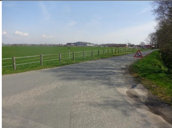
Abb.: Kreuzung mit geringen Straßenschäden und Baustellenschild
