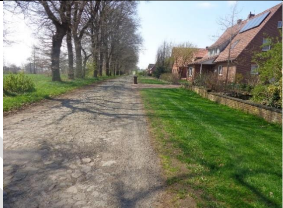
Abb.: Zufahrtsstraße in schlechtem Zustand
