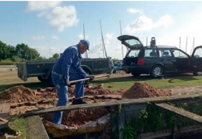
Ein Bild, das sich nicht so schnell wiederholen soll: Der SCC-Hafenwart Bernard Wehri repariert ein gebrochenes Stück der alten Spundwand. (Fotos: Segler-Club Clarholz)
